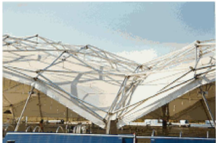
Obr., Spektakulárne nosné konštrukcie nesúce membránové opláštenie, - a/ , b/, spodné a horné umiestnenie
