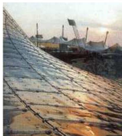
Obr., a/ Expo 1967, Montreal - nemecký pavilón, architekt Frei Otto, textilná membrána bodovo zavesená b/ Olympijský areál Mníchov - 1972, architekt Gunter Benisch, membrána skladaná z plexisklových platní, nesená lanovou konštrukciou
