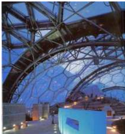
Obr., Spektakulárne nosné konštrukcie nesúce membránové opláštenie, - a/ , b/, spodné a horné umiestnenie
