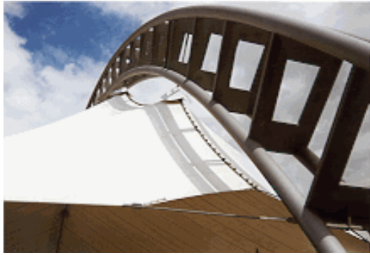
Obr., Precízne pojednanie technického detailu „, technický exhibicionizmus „, – a/ vonkajší nosný rám membránového opláštenia, b/ detail prestupu nosného piliera membránovou strešnou konštrukciou
