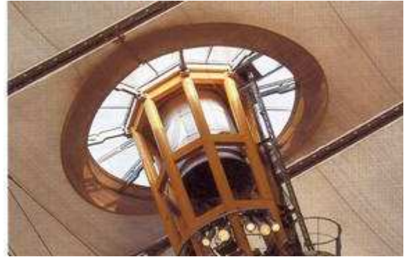
Obr., Precízne pojednanie technického detailu „, technický exhibicionizmus „, – a/ vonkajší nosný rám membránového opláštenia, b/ detail prestupu nosného piliera membránovou strešnou konštrukciou
