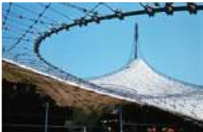
Obr., a/ Expo 1967, Montreal - nemecký pavilón, architekt Frei Otto, textilná membrána bodovo zavesená b/ Olympijský areál Mníchov - 1972, architekt Gunter Benisch, membrána skladaná z plexisklových platní, nesená lanovou konštrukciou
