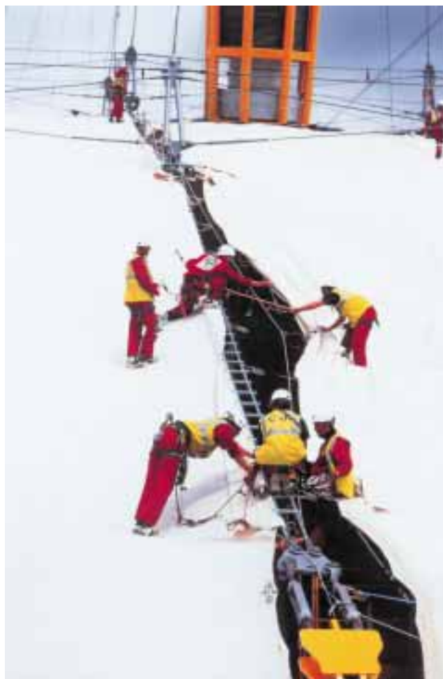
Obr. 17 Hala Milénium, Londýn (proces uzatvárania membránových prefabrikátov)
