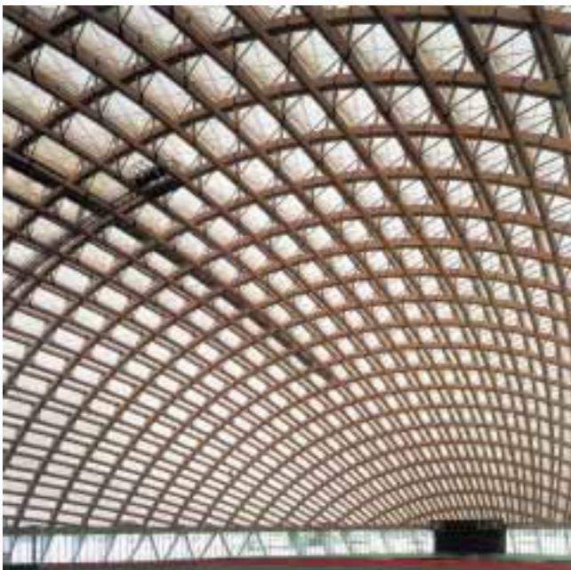
Obr. 12 Športová hala, Odate, JPN architekti: Toio-Ito & Ass. Tokio a Takenaka Corporation, Tokio (membrána napínaná metódou okrajového napnutia – nosná konštrukcia mrežová štruktúra z drevených lepených nosníkov) rozpon 142 m – pohľad, pohľad do interiéru haly
