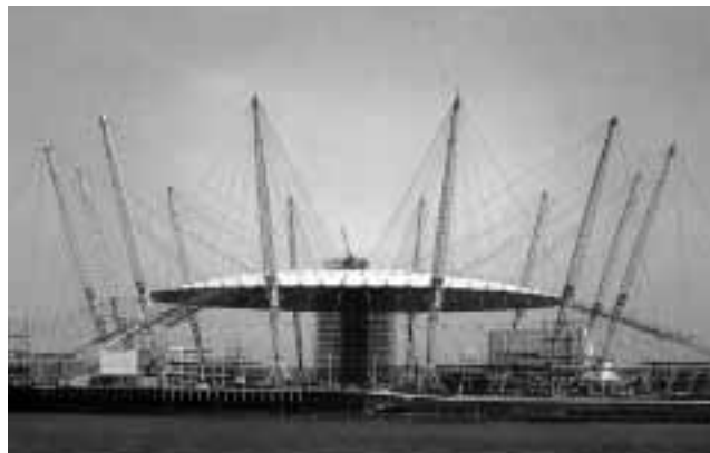
Obr. 16 Hala Milénium, Londýn (proces vyvažovania konštrukcie a napínania membrány)
