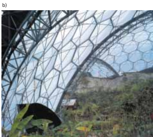
Obr. 3 Eden projekt, Cornwall, GB architekt Nicolas Grimshaw and Partners (membránová štruktúra – aplikácia modifikovaných foriem, forma vyplývajúca z prírodných funkcií s uplatnením vonkajšej hexagonálnej štruktúry) – a) plán zastrešenia, b) pohľad do interiéru
