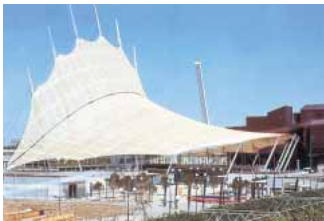
Obr. 1 „Diadema“ pavilón Expo 92 Sevilla, SP dodávateľ: CENO-TEC (membránová strecha pavilónu – aplikácia organickej formy) – pohľad
