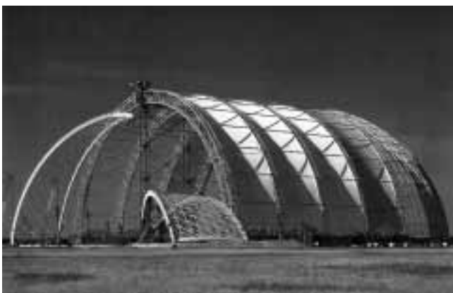
Obr. 13 Hangár pre vzducholode fi CARGOLIFTER, GBR (membrána napínaná metódou okrajového napnutia – nosná konštrukcia oceľová štruktúra) rozpon 210 m – pohľad na montáž haly
