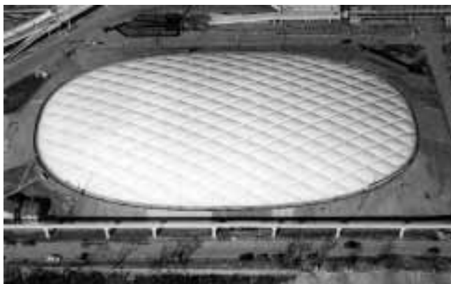
Obr. 14 US Pavilon, Svetová výstava Osaka 1970 architekti : Davis Brody, Geiger Berger Ass (membrána napínaná metódou vnútorného pretlaku) rozpon 142 m – pohľad na strechu
