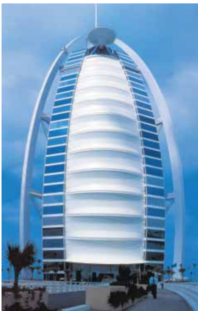
Obr. 6 Hotel Burj Al Arab Dubai, FA architekti W.S. Atkins, Associates (uzavretie hotelovej haly výškovej stavby membránou PTFE) – pohľad, pohľad z interiéru na uzatvárajúcu membránu
