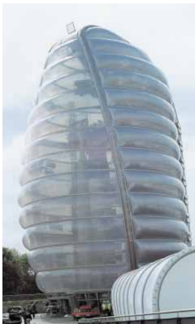
Obr. 8 Národné vesmírne centrum Leicester, GBR architekti: Nicolas Grimshaw ass. (opláštenie 140 m vysokej „Raketovej haly“ dvojplášťovou vankúšovou membránou) – pohľad
