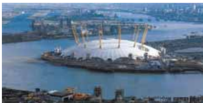
Obr. 10 Hala Milénia Londýn, GB architekti: Richard Rogers, Partnership (membrána napínaná metódou okrajového napnutia – uplatnenie lanovej skruže) celkový pohľad, pôdorys strechy
