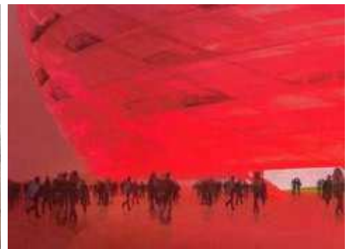
Obr.17,18 Futbalový štadión, Mníchov, D, architekti Herzog and de Mueron, konštrukcia prestrešenia pozostávajúca z translucenčných a transparentných pneumatických prvkov, celkový pohľad, farebné dotvorenie svetelnou clonou
