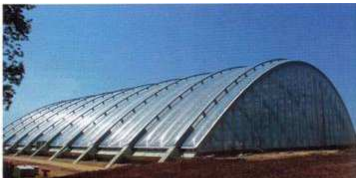
Obr.13 Masoala Reinforest House, Zurich, SCH, architekt: Gautschi-Stoner, Zurich, oblúkové prestrešenie z pneumatických polí šírky cca 4,0 m, dĺžky 106 m, exteriérový pohľad
