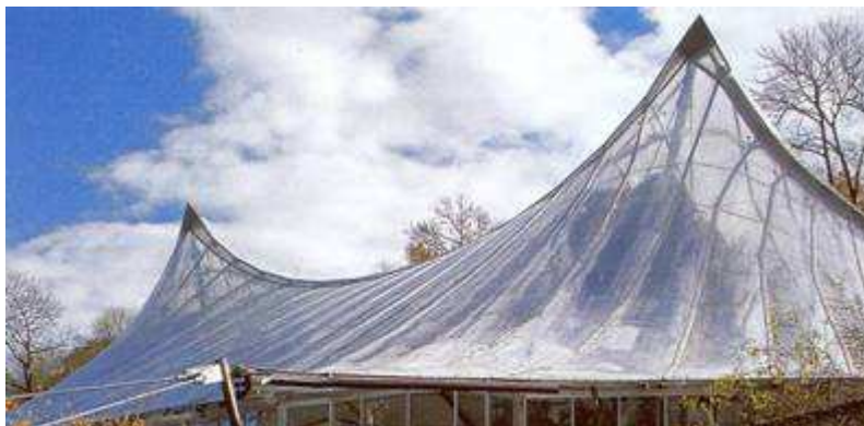
Obr.4. Pavilón pre šelmy v Hellabrunn, Mníchov, D, architekt: Herbert Kochta, konštrukcia: IPL Schlaich, Bergemann und Partner, antiklastická atypická pneumatická konštrukcia zastrešenia nesená lanovou sieťou, pohľad
