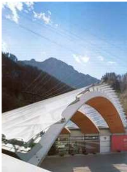
Obr. 15,16 Informačné centrum Walchenseekraftwerk in Kochel am See, D, prestrešenie jednoplášťovou mechanicky predpäťou fóliou, celkový pohľad, detail montáže
