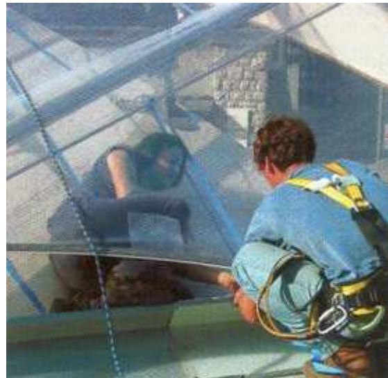
Obr. 15,16 Informačné centrum Walchenseekraftwerk in Kochel am See, D, prestrešenie jednoplášťovou mechanicky predpäťou fóliou, celkový pohľad, detail montáže
